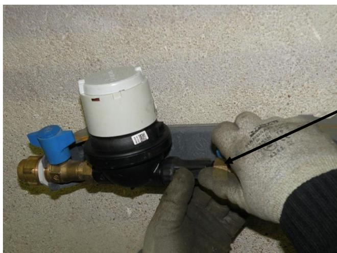
Serrage manuel du produit aval sur le filetage de l'allonge avant finalisation à la clé.
